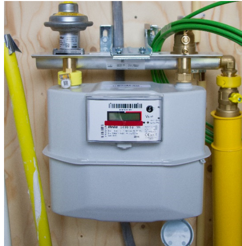
Gasmeter (meterkast)
