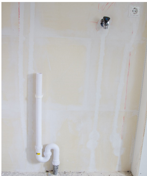
Aansluitpunt wasmachine (standaard aanwezig)
