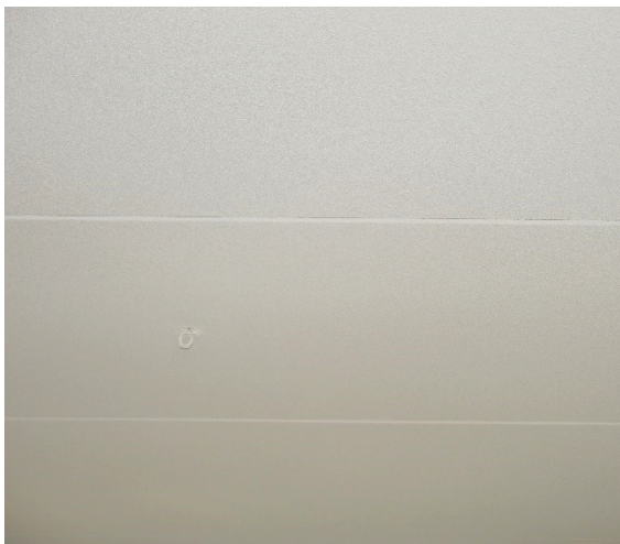
Spuitwerk plafond, V-naden blijven in het zicht
