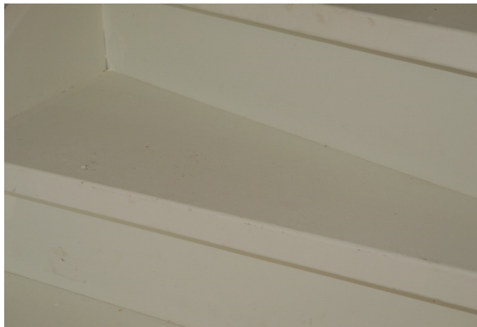
Massieve stootborden voorzijde trap (2N01) In de achterzijde blijven schroefgaten in het zicht
