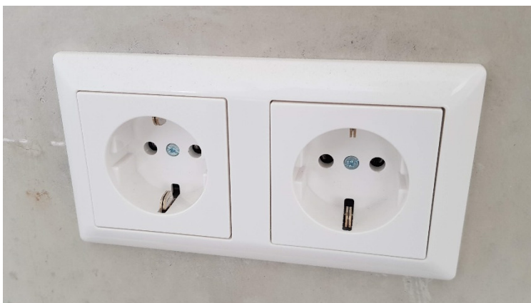
Dubbele wandcontactdoos (2C02)
