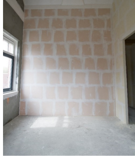
Binnenwand behangklaar afgewerkt
