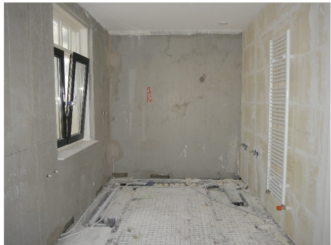
Casco badkamer, wordt opgeleverd zonder dekvloer
