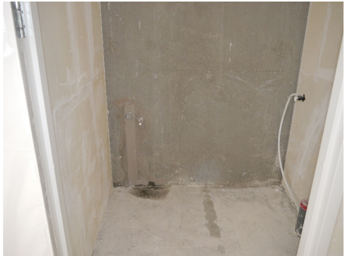
Casco toilet, wordt opgeleverd met dekvloer
